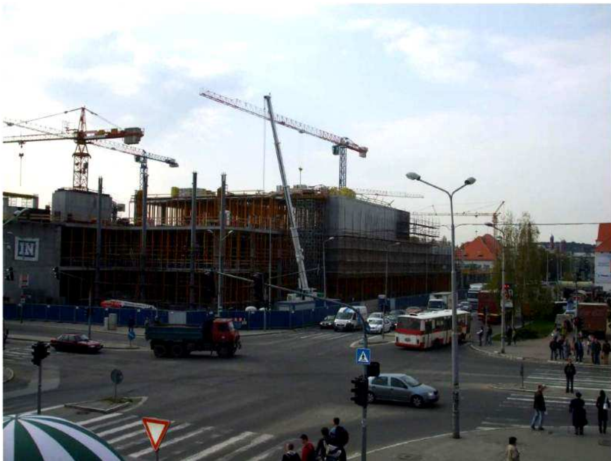
Stavba nákupného komplexu v Nitre
