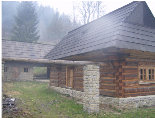
zrekonštruovaný zrubový dom
