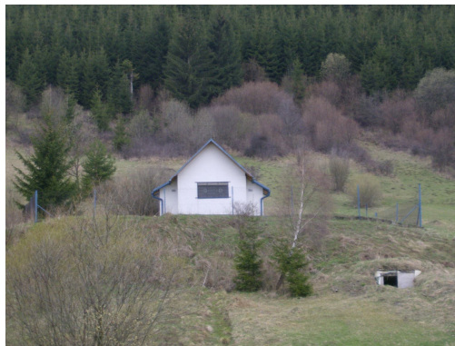
rezervoár pitnej vody
