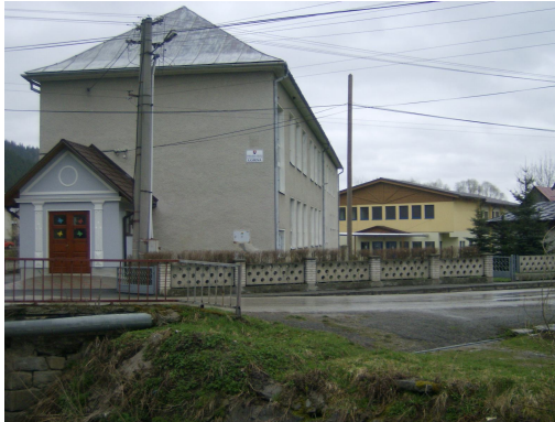
základná škola v pozadí telocvičňa
